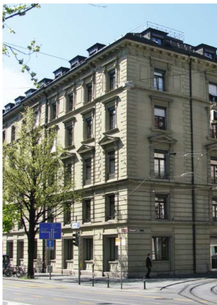
Dal 1916 sede dell'AFC: Bundesgasse 32. Foto: Archivio federale svizzero
